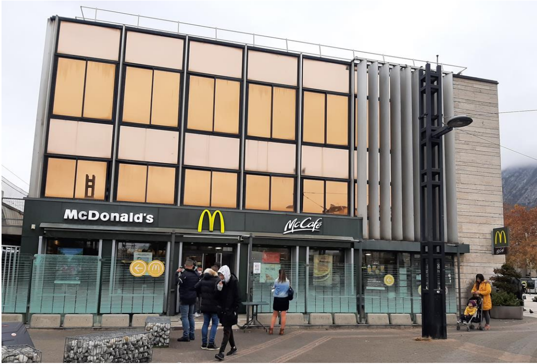
Photo de l'emplacement concerné en gare de Grenoble
